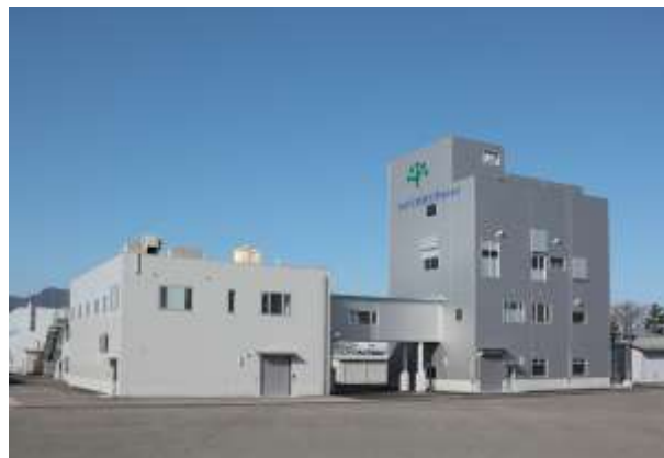
左側: 粉碎設備棟、右側: 精製設備棟
